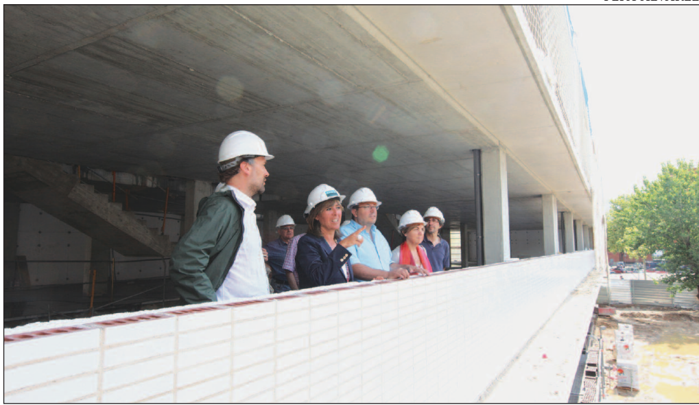
Núria Marín y Lluís Esteve, en el centro, en una visita reciente al edificio en construcción
